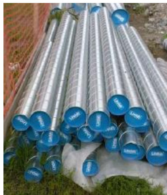
Exemple de stockage de conduits à éviter (exemple français à gauche) et à privilégier (exemple finlandais à droite). Source : Cetiat
