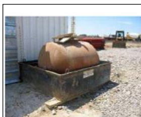
Bac de protection pour cuve fuel
