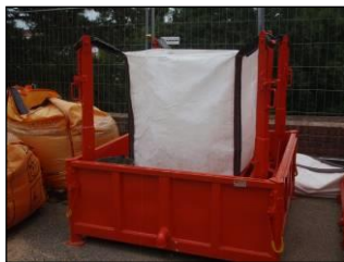
Décantation de l'eau de lavage des outils
